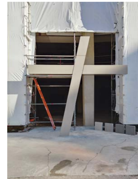
4 L'exosquelette du bâtiment Zola The exoskeleton of the Zola Building
